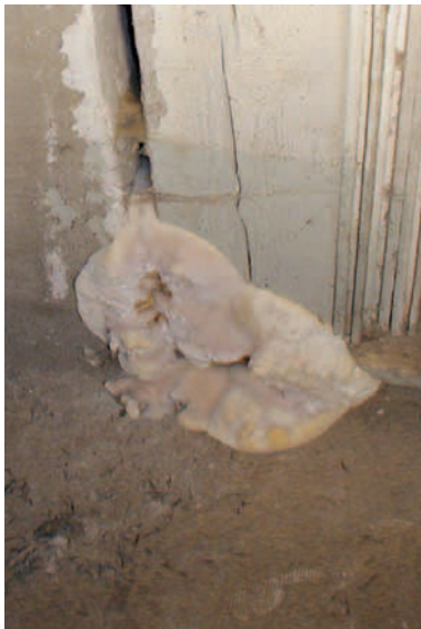
Fruchtkörper zwischen Mauerwerk und Kellerverschlagspfosten
