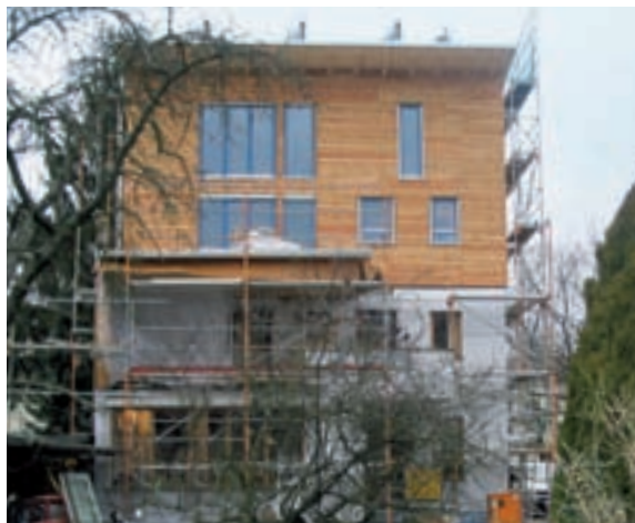
Das aufgestockte Gebäude von der Südseite
